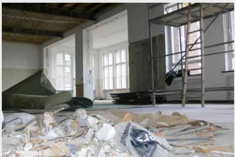
Der alte Handarbeitsraum ist kaum wiederzuerkennen: ohne Mobiliar und Schränke, dafür mit sehr viel Bauschutt. Hier entsteht ein großer Meditationsraum, der auch andere Gottesdienstformen zulassen wird.
